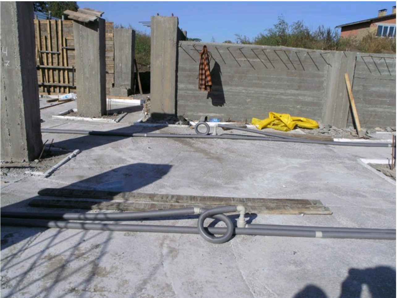
Рис.2 Сезонний ґрунтовий акумулятор тепла. с.Обухівка, Дніпропетровська обл.
